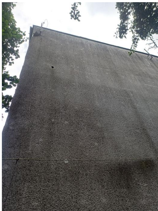
Fot. 10. Wydziobane przez dzięcioła ubytki w elewacji, ściana szczytowa internatu.
